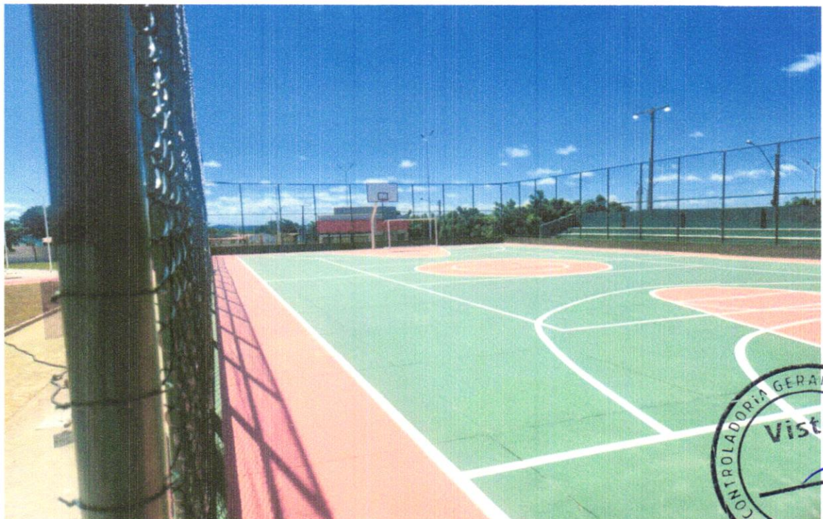
FOTO 26 – PINTURA ACRÍLICA DE FAIXAS DE DEMARCAÇÃO EM QUADRA POLIESPORTIVA
