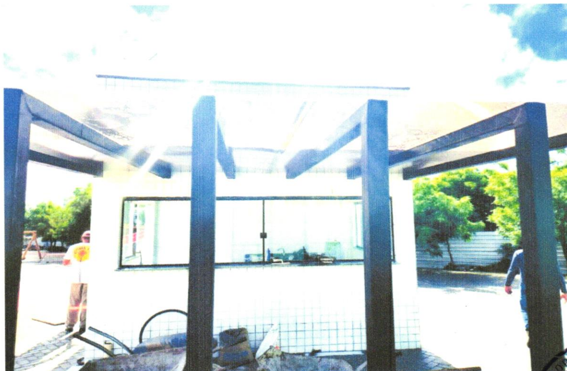
FOTO 14 – FORNECIMENTO E INSTALAÇÃO DE CHAPAS DE POLICARBONATO
