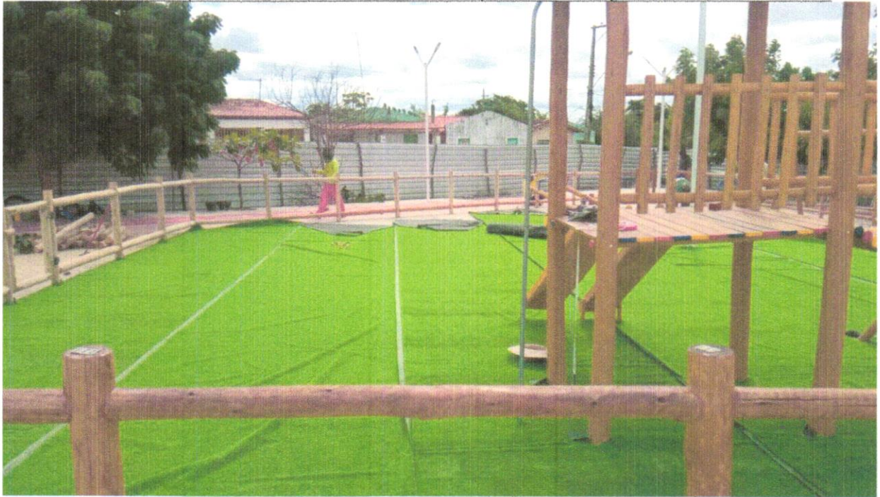
FOTO 67 – FORNECIMENTO E INSTALAÇÃO DA GRAMA SINTÉTICA
