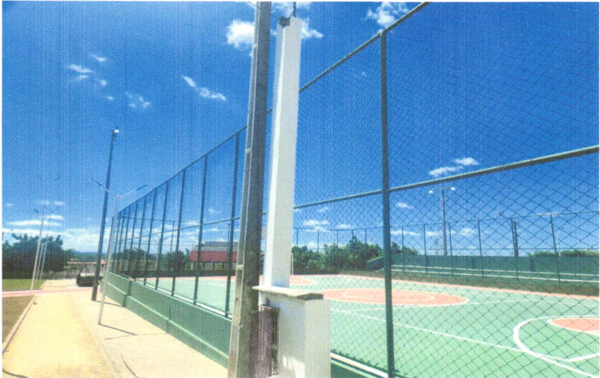
FOTO 39 – EMASSAMENTO E LIXAMENTO DO POSTE
