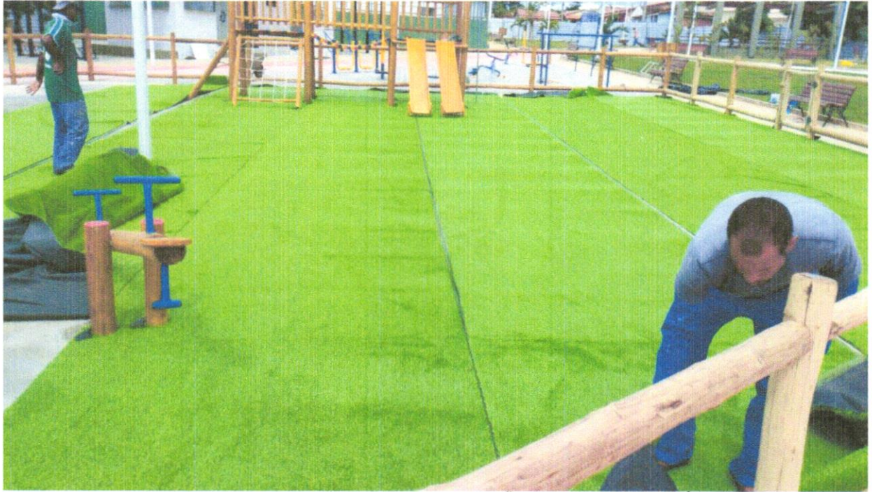
FOTO 69 – FORNECIMENTO E INSTALAÇÃO DA GRAMA SINTÉTICA
