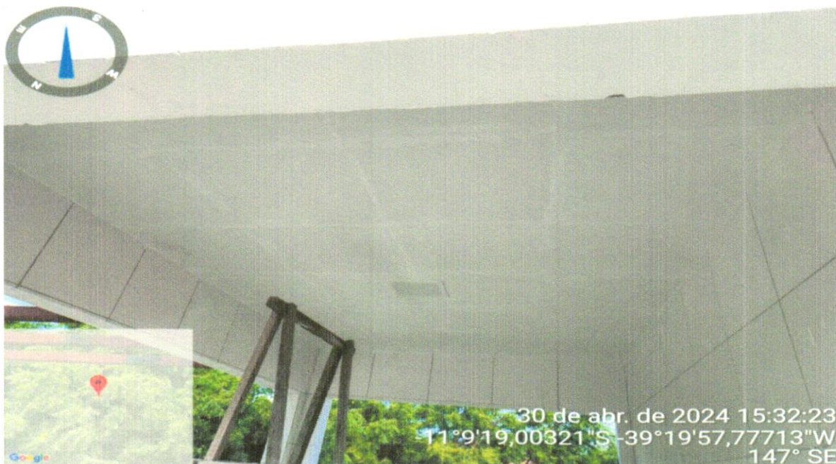
FOTO 05 - FORRO EM PLACAS DE GESSO, PARA AMBIENTES COMERCIAIS
