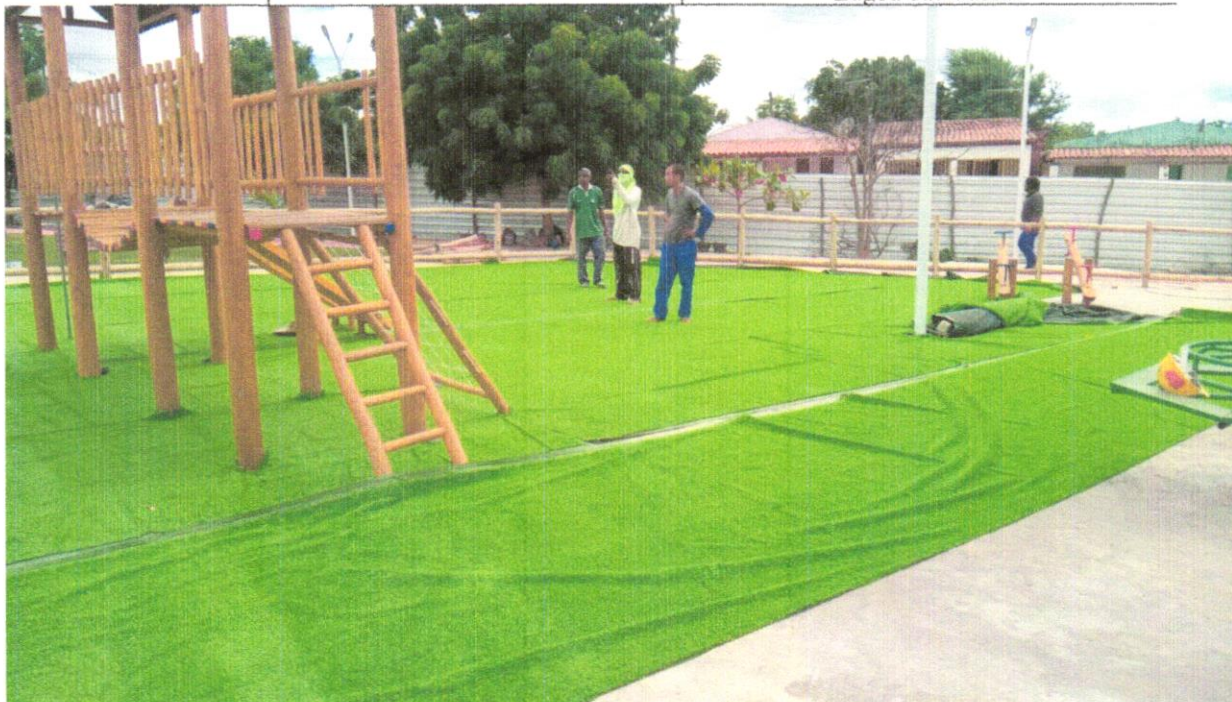
FOTO 71 – FORNECIMENTO E INSTALAÇÃO DA GRAMA SINTÉTICA
