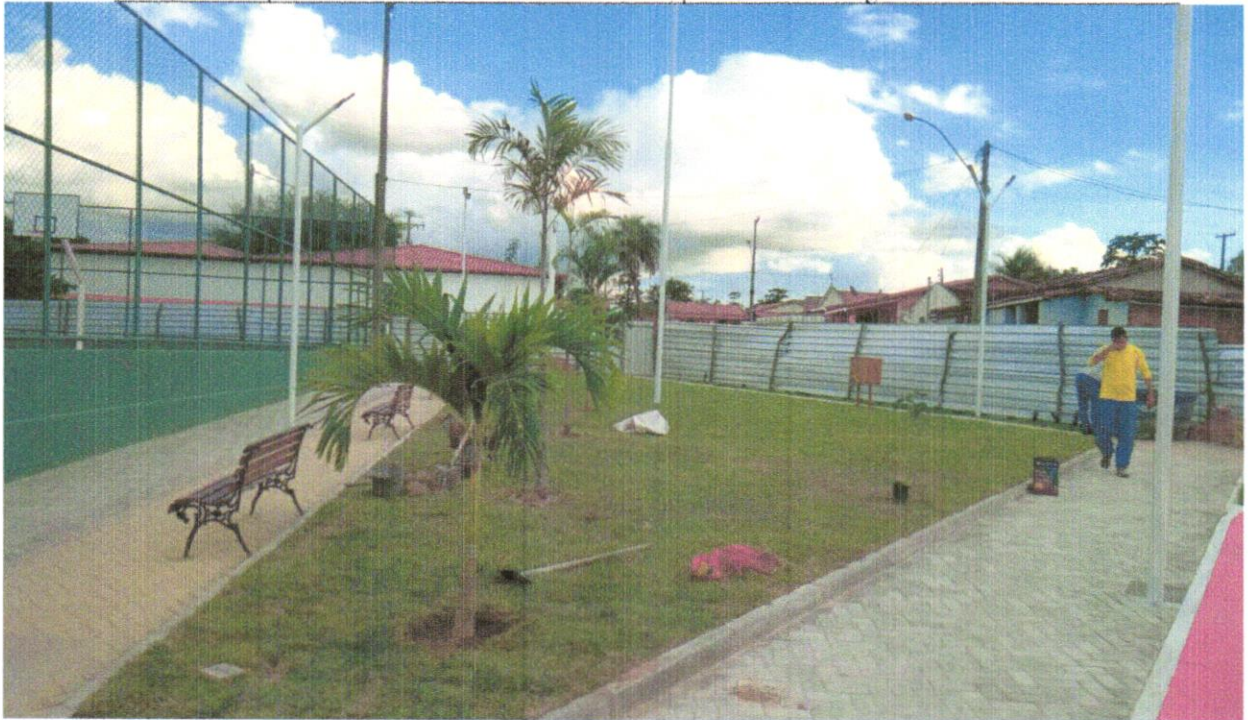
FOTO 63 – FORNECIMENTO E PLANTIO DE PALMEIRA
