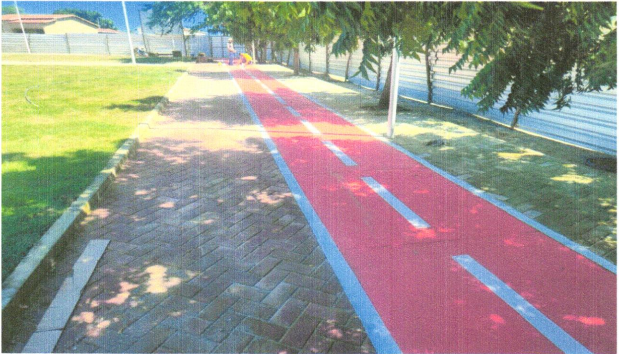
FOTO 59 – PINTURA DA PISTA DE CICLOVIA COM TINTA VIÁRIA
