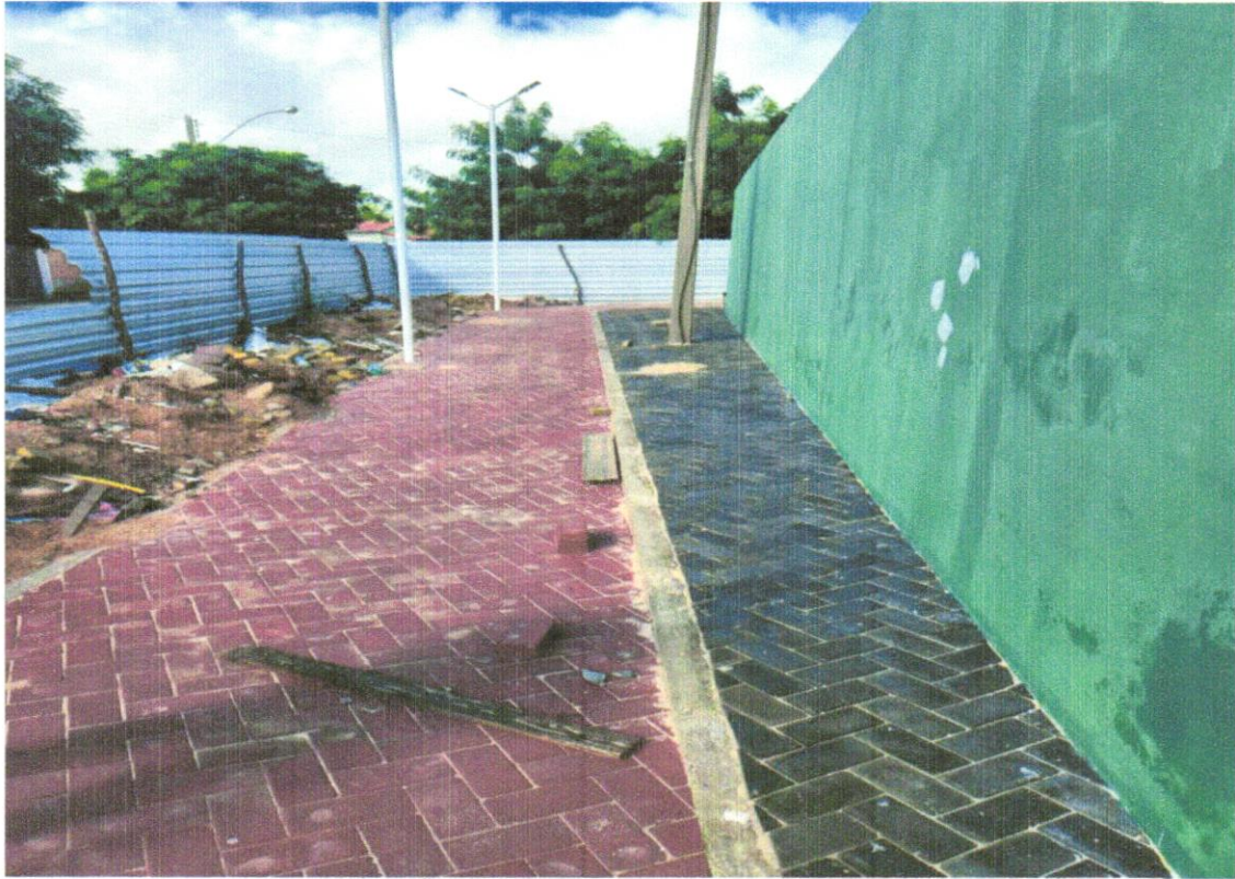
FOTO 19 – EXECUÇÃO DE PINTURA DA PAREDE DA ARQUIBANCADA
