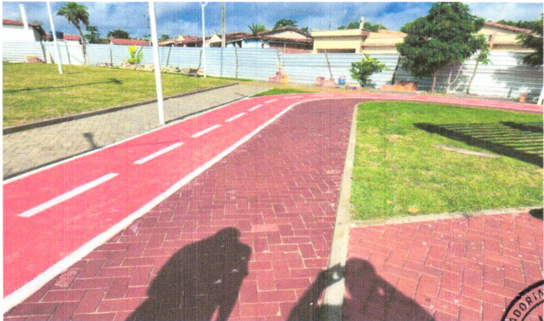
FOTO 20 – EXECUÇÃO DE PINTURA DA PISTA DE CICLOVIA
