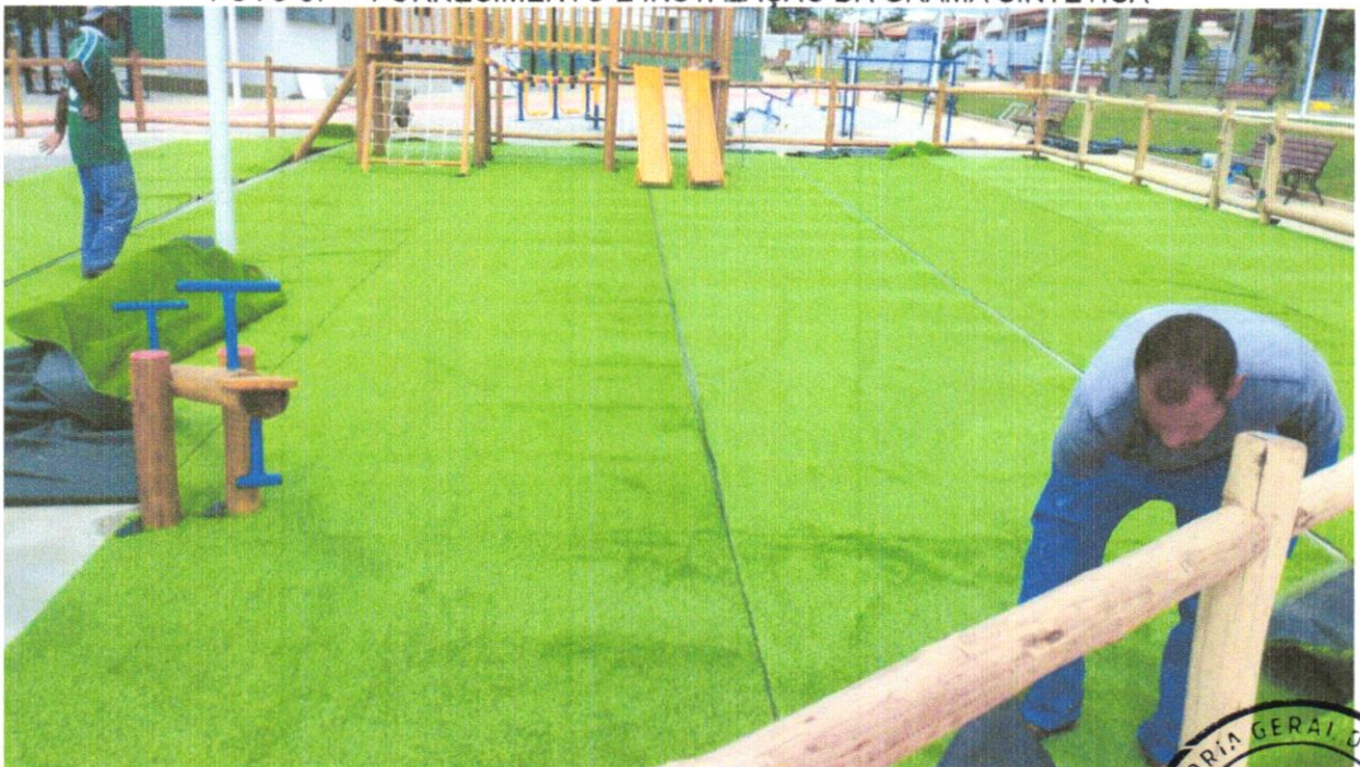
FOTO 68 – FORNECIMENTO E INSTALAÇÃO DA GRAMA SINTÉTICA
