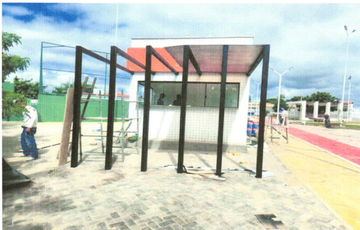
FOTO 13 – FORNECIMENTO E INSTALAÇÃO DE CHAPAS DE POLICARBONATO
