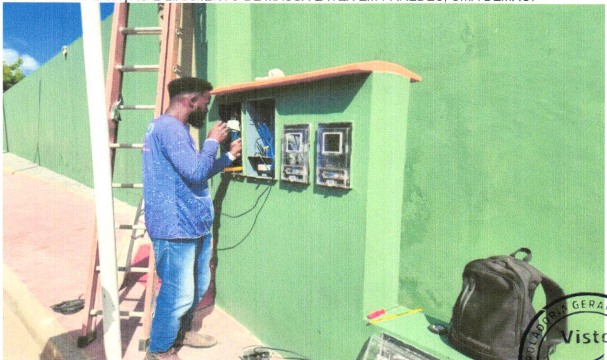
FOTO 50 – INSTALAÇÃO DO PADRÃO DE ENERGIA
