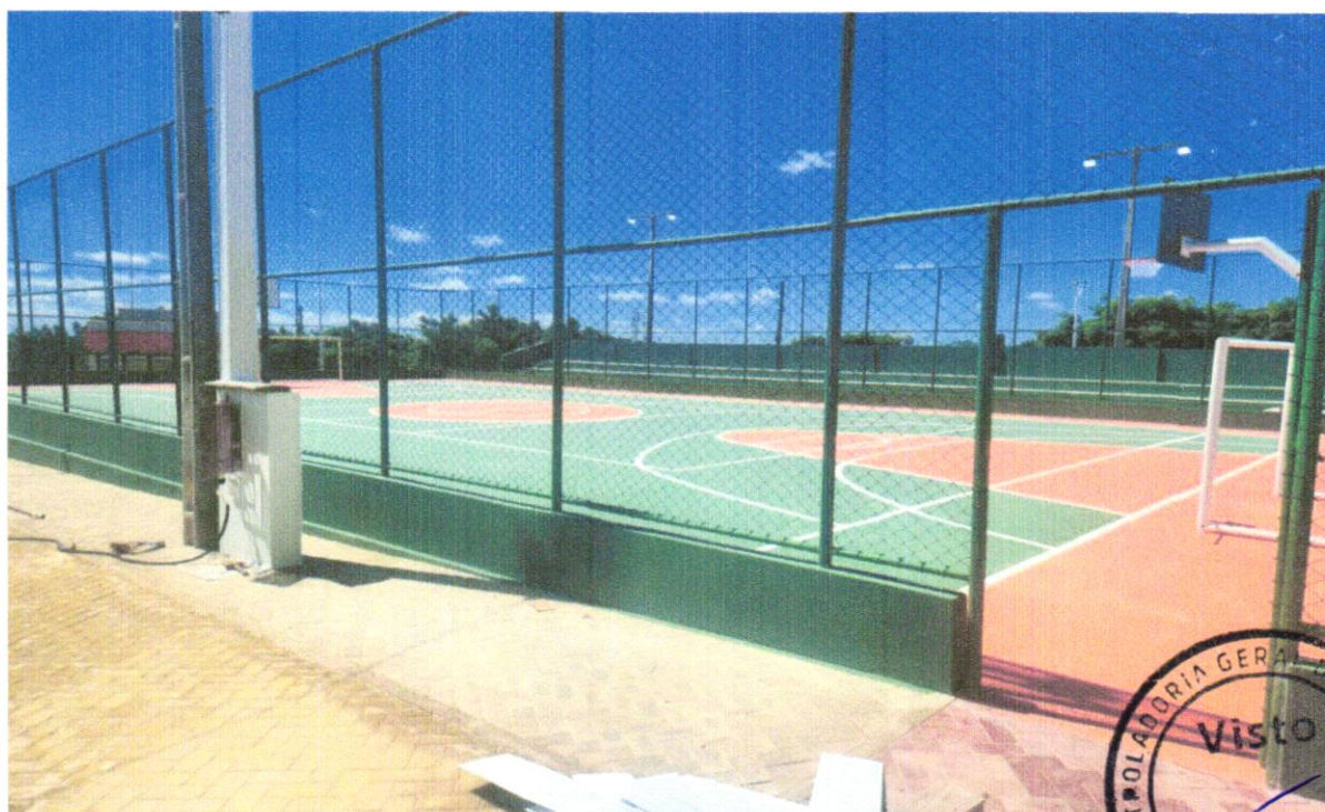
FOTO 38 – INSTALAÇÃO DAS LUMINÁRIAS
