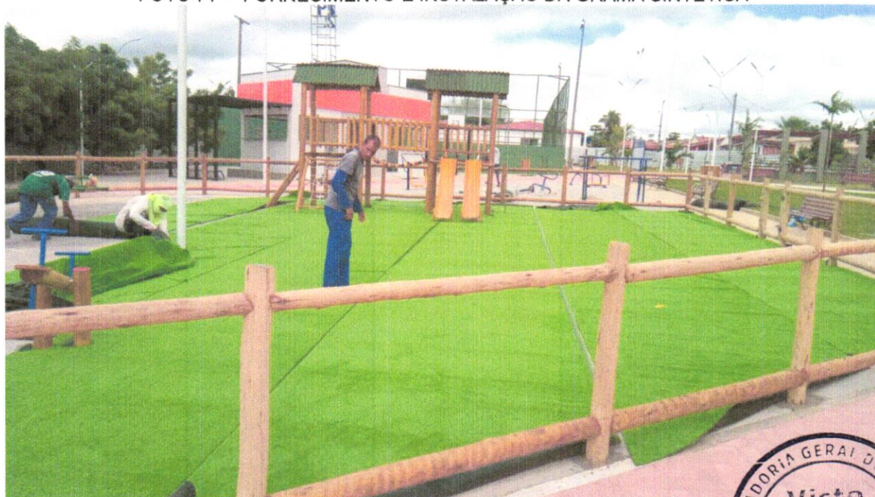
FOTO 72 – FORNECIMENTO E INSTALAÇÃO DA GRAMA SINTÉTICA
