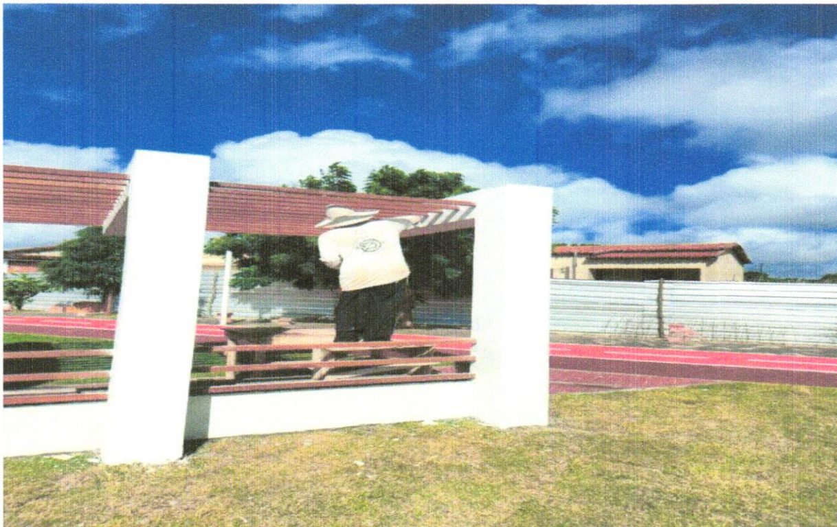
FOTO 47 – APLICAÇÃO E LIXAMENTO DE MASSA LÁTEX
