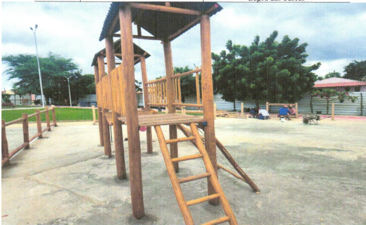
FOTO 51 – FORNECIMENTO E INSTALAÇÃO DE BRINQUEDOS
