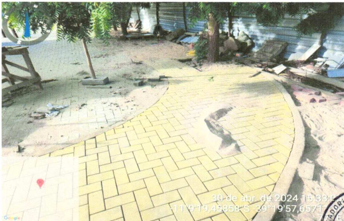
FOTO 16 – EXECUÇÃO DE PÁTIO/ESTACIONAMENTO EM PISO INTERTRAVADO
