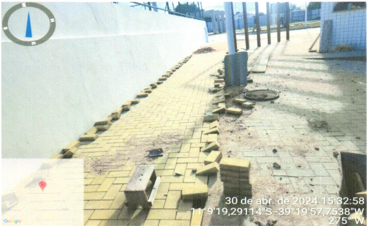
FOTO 17 – EXECUÇÃO DE PÁTIO/ESTACIONAMENTO EM PISO INTERTRAVADO
