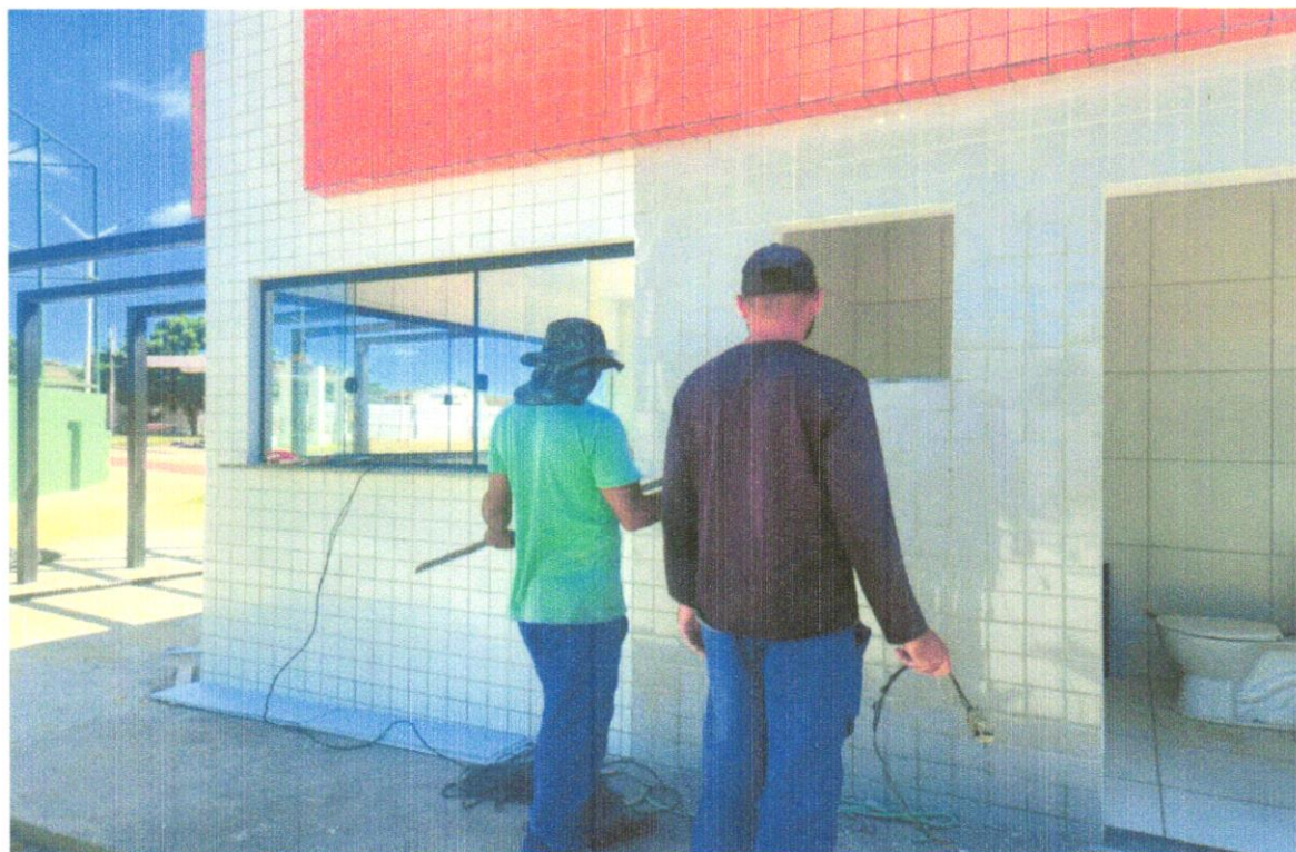
FOTO 11 – JANELA DE ALUMÍNIO TIPO MAXIM-AR
