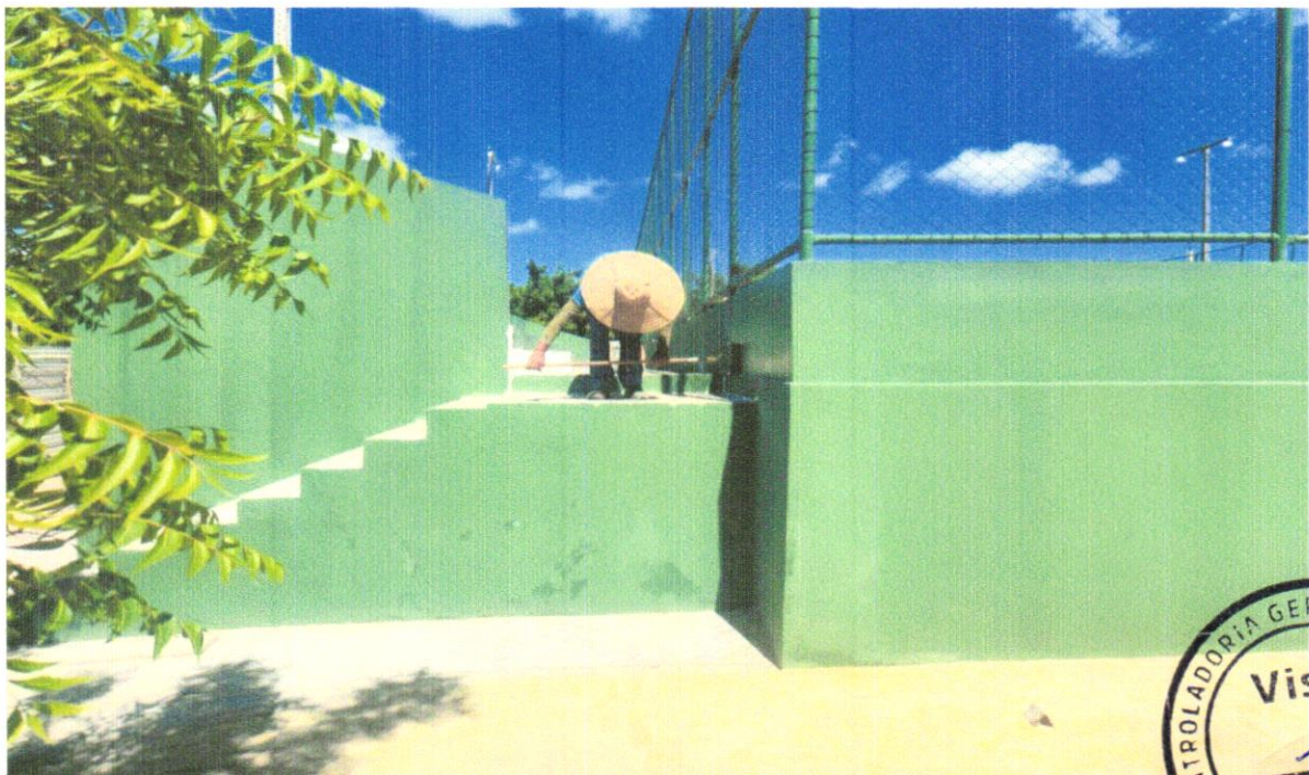
FOTO 40 – PINTURA DE ACABAMENTO COM APLICAÇÃO DE 01 DEMÃO DE TINTA
