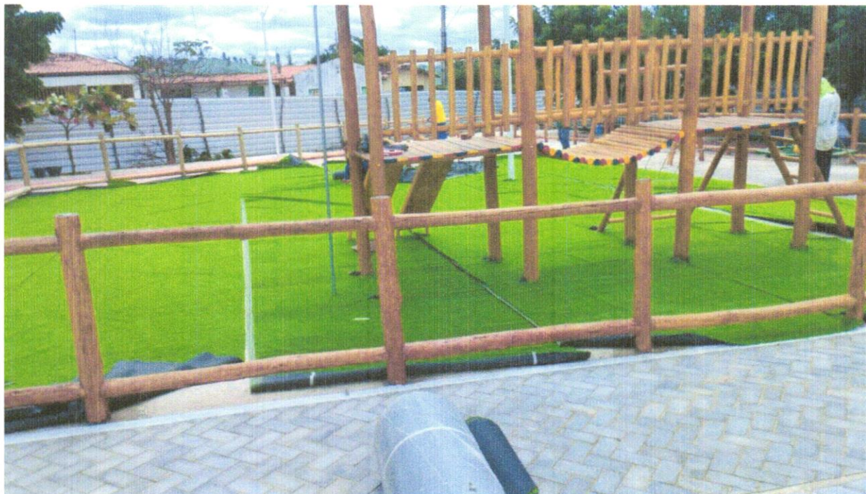
FOTO 65 – FORNECIMENTO E INSTALAÇÃO DA GRAMA SINTÉTICA
