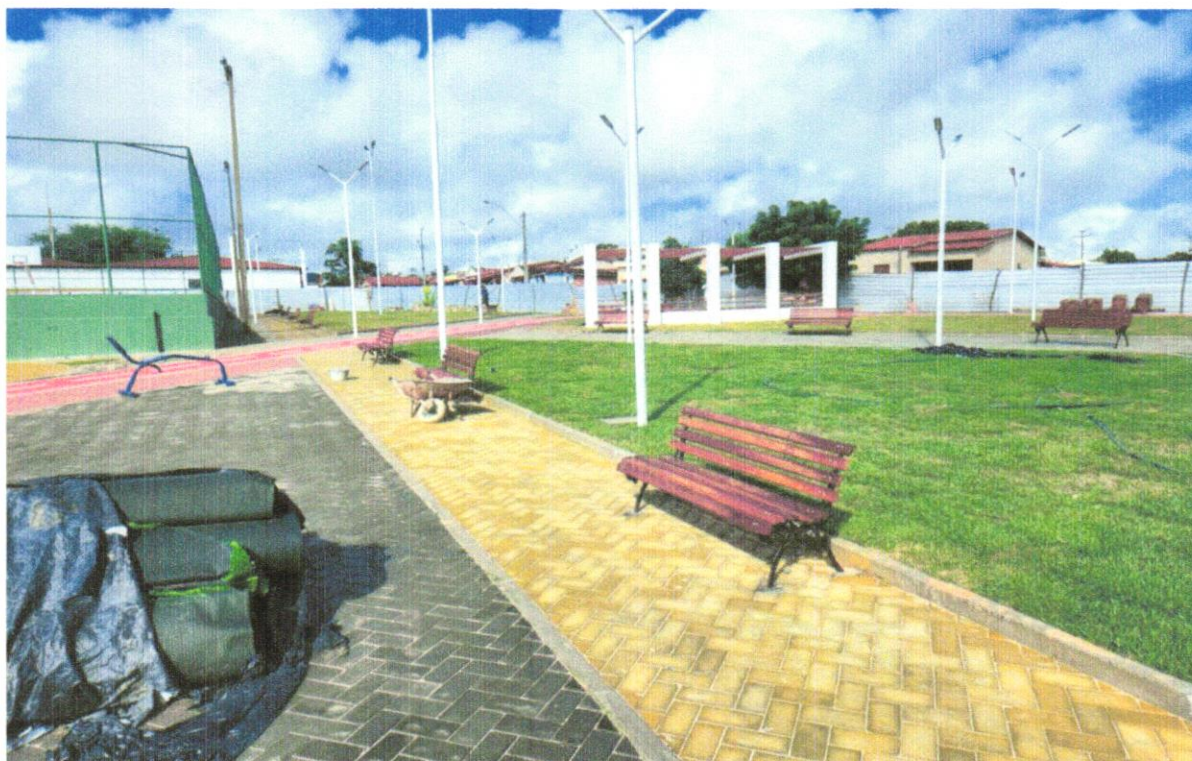
FOTO 37 – FORNECIMENTO E INSTALAÇÃO DE BANCO DE MADEIRA
