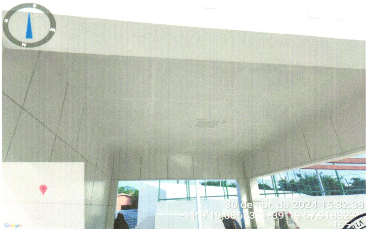
FOTO 04 – FORNECIEMNTO E INSTALAÇÃO DE LUMINÁRIAS
