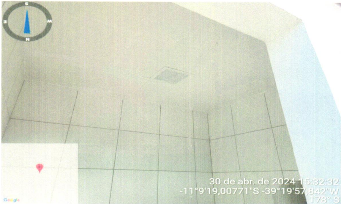
FOTO 03 – FORNECIMENTO E INSTALAÇÃO DE LUMINÁRIAS
