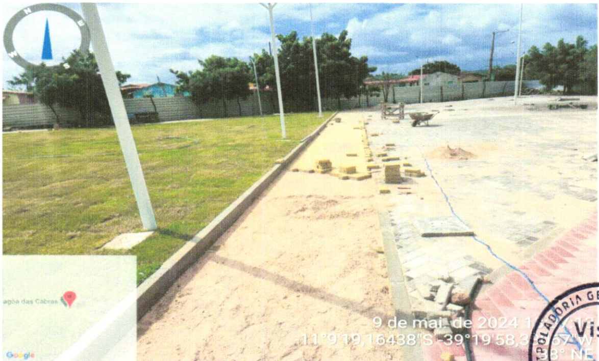
FOTO 18 – EXECUÇÃO DE PÁTIO/ESTACIONAMENTO EM PISO INTERTRAVADO
