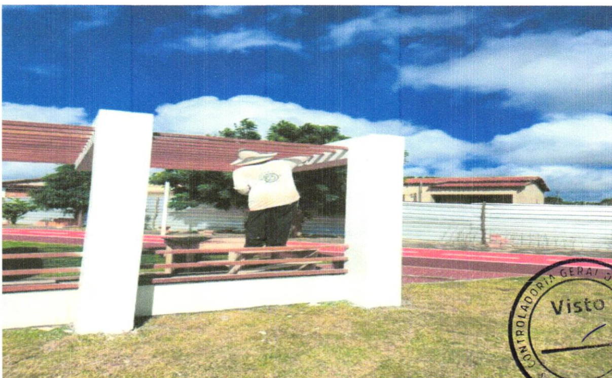
FOTO 32 – MADEIRAMENTO EM MASSARANDUBA/MADEIRA DE LEI, SERRADA 5 CM X 5 CM
