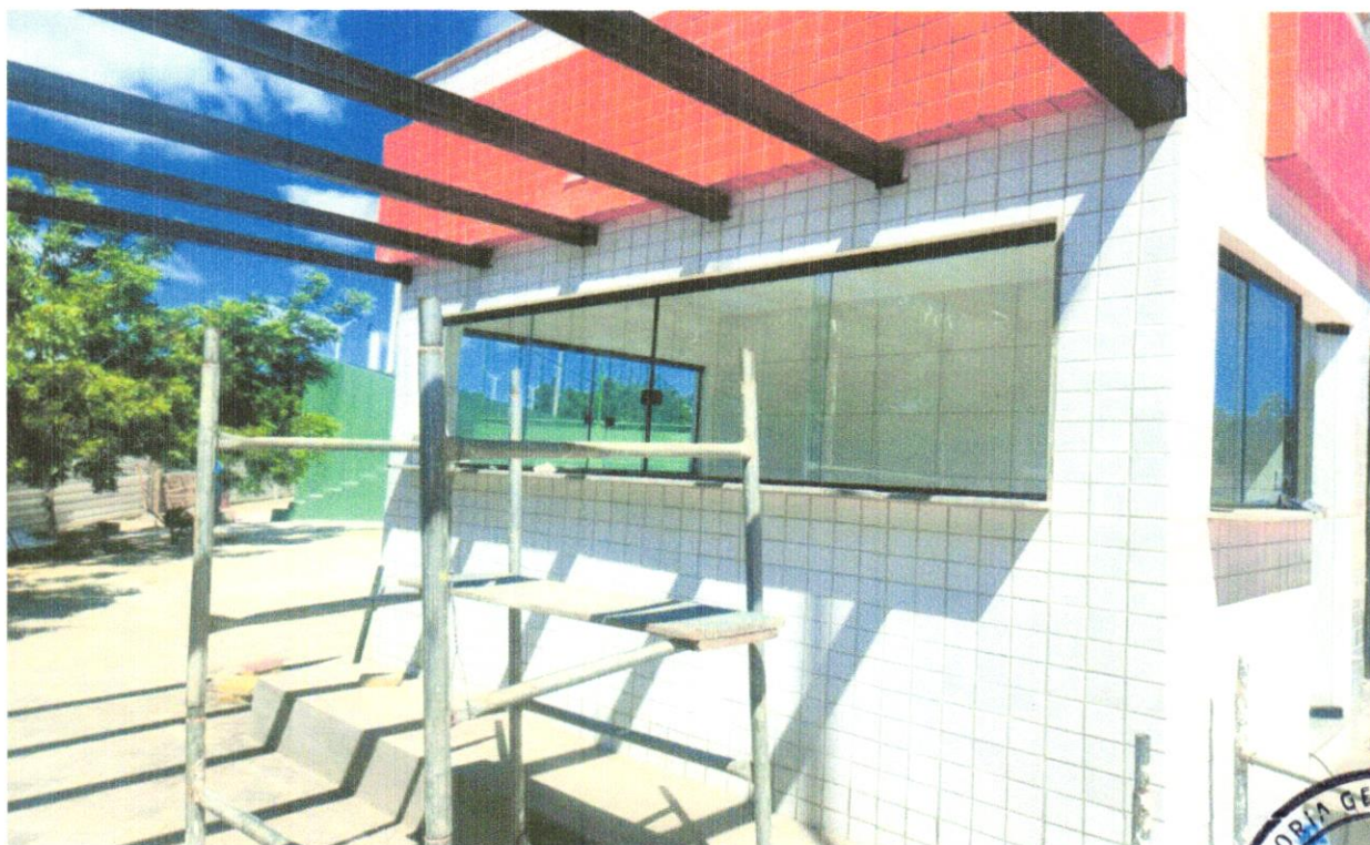
FOTO 10 – FORNECIMENTO E INSTALAÇÃO DE ESQUADRIAS
