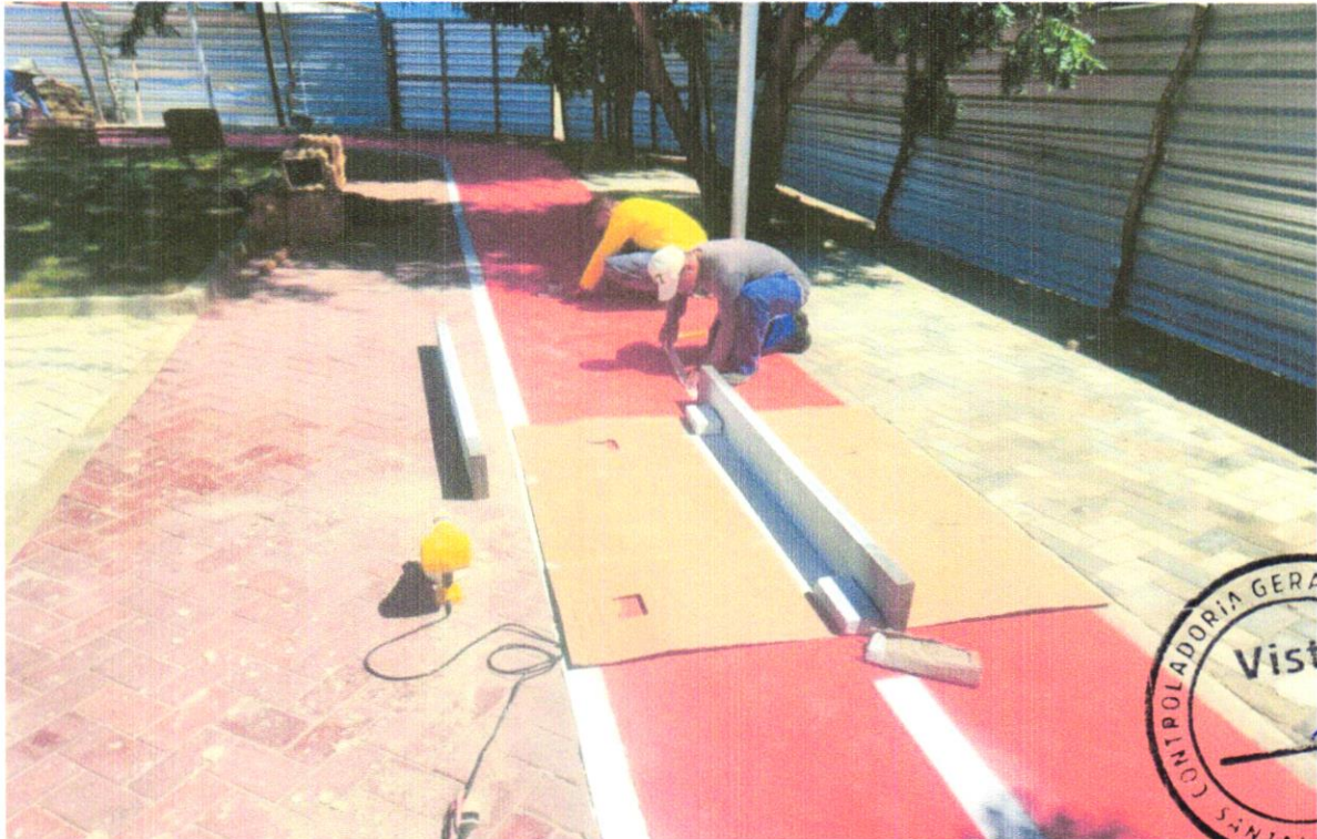
FOTO 58 – PINTURA DA PISTA DE CICLOVIA COM TINTA VIÁRIA
