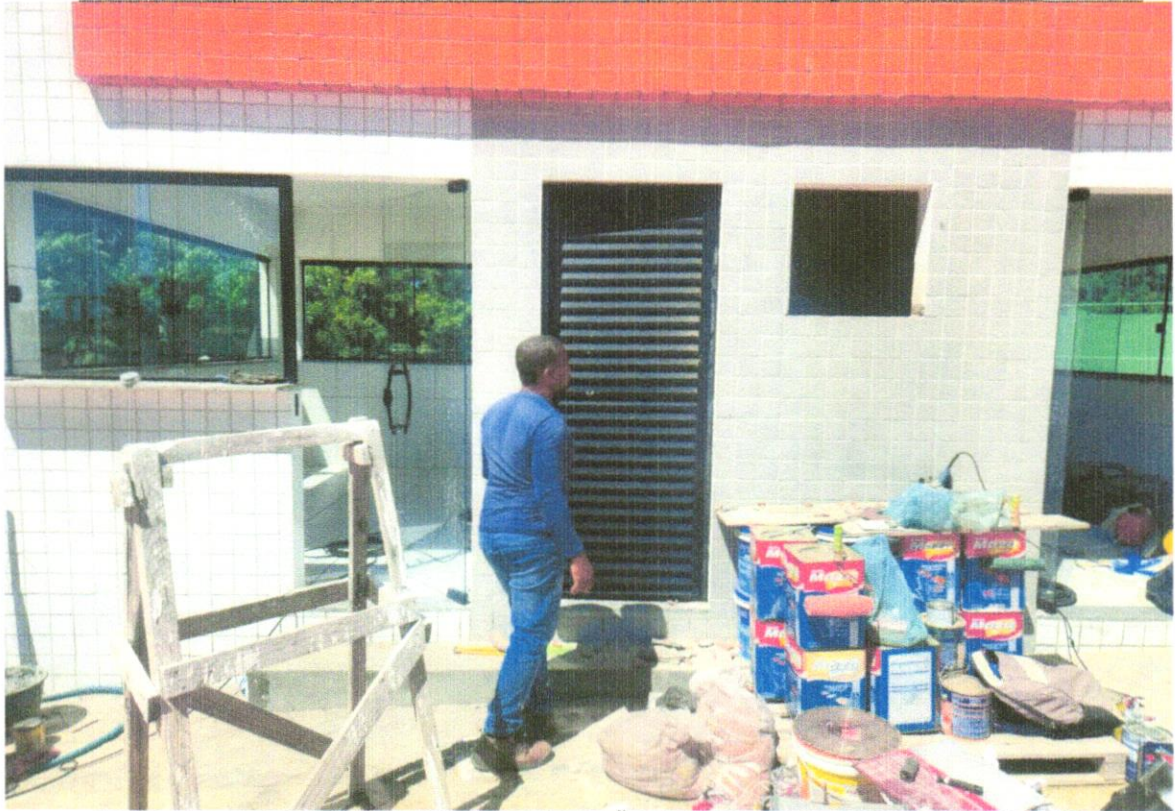
FOTO 57 – FORNECIMENTO E INSTALAÇÃO DE PORTA E JANELA VENEZIANA
